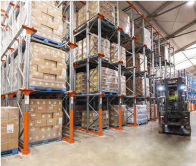
Estanterías de paletización compacta
