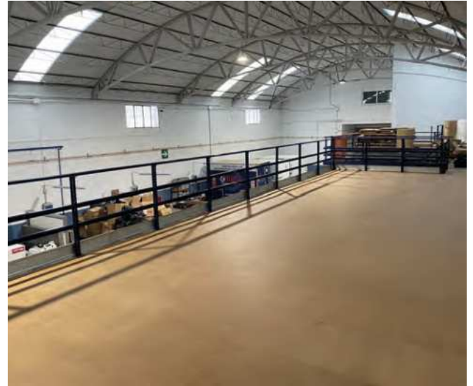
Zona diáfana superior del altillo metálico
